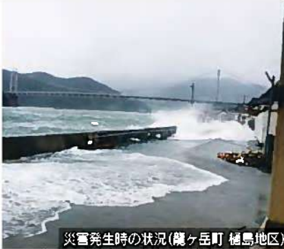
災害発生時の状況(薩ヶ岳町 樋島地区)
